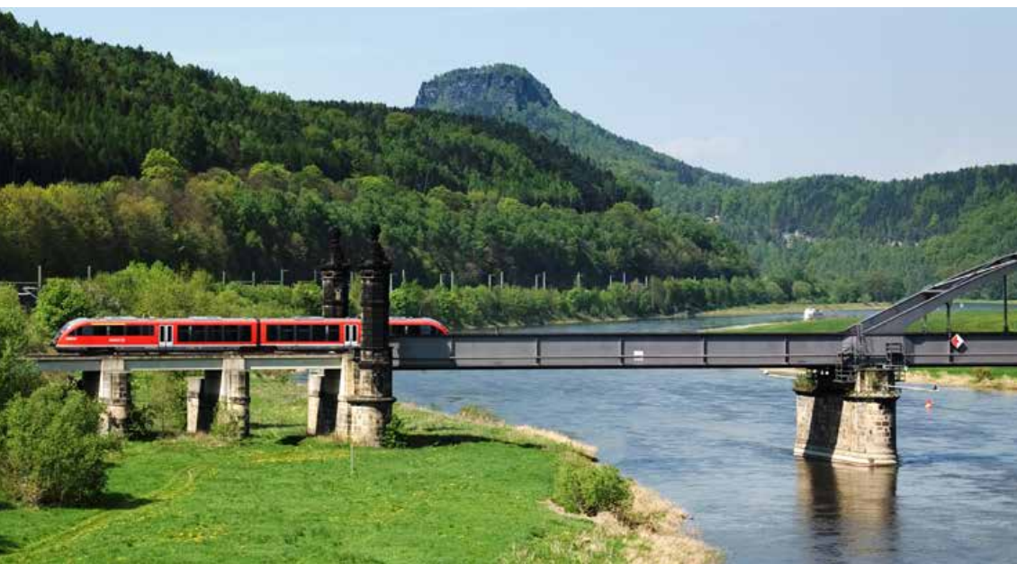
Die neue Nationalparkbahn auf der Eisenbahnbrücke in Bad Schandau
